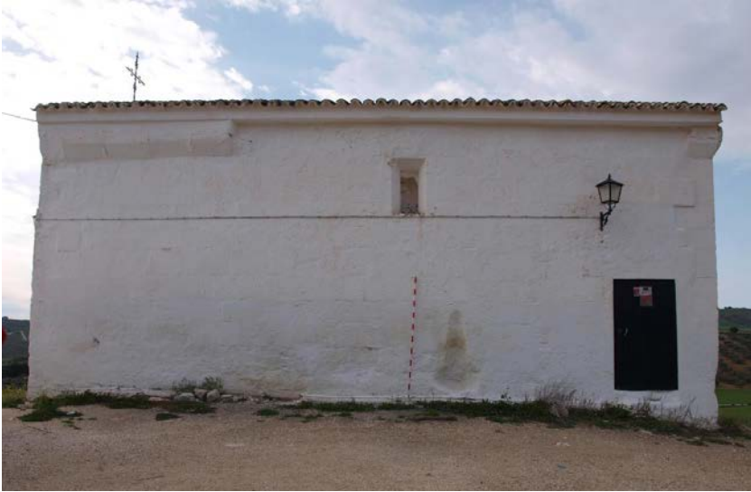
Fig.4. Rebaje exterior de los sillares del muro S.
